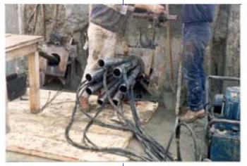
Montaggio cella di carico mod. EL295
