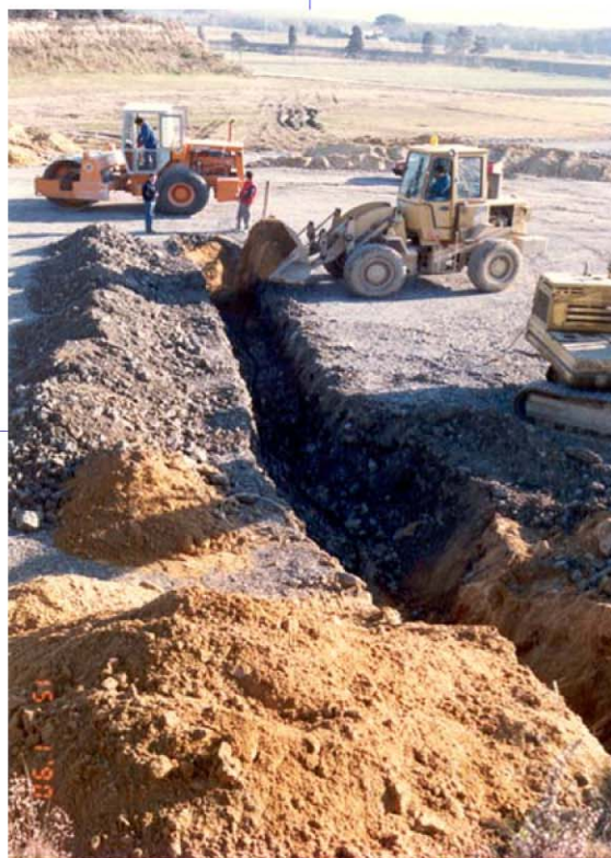
Rilevato in costruzione
